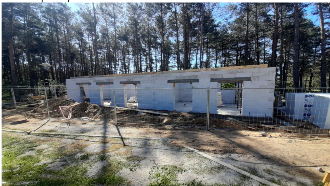
Budynek szatni w Krzywogórcu w trakcie budowy.
