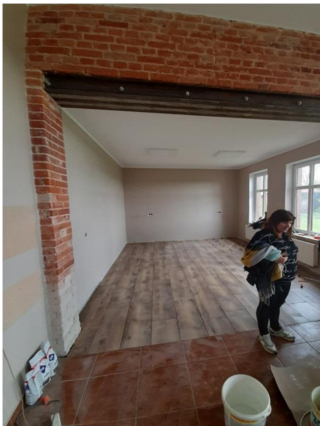
W trakcie remontu w świetlicy wiejskiej w Brzoziu.
