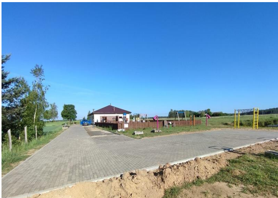
Utwardzony plac przy świetlicy wiejskiej i placu zabaw w Zalesiu.
