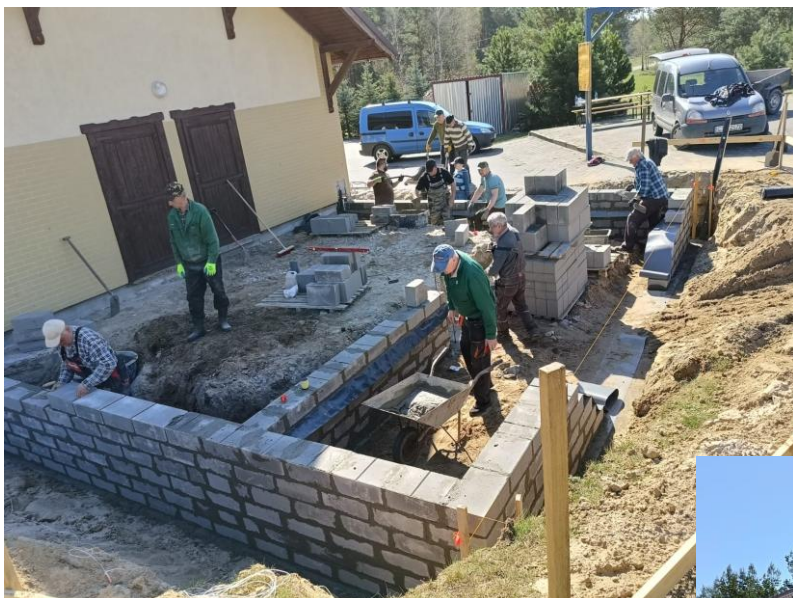
Prace budowlane przy rozbudowie świetlicy w Wysokiej
