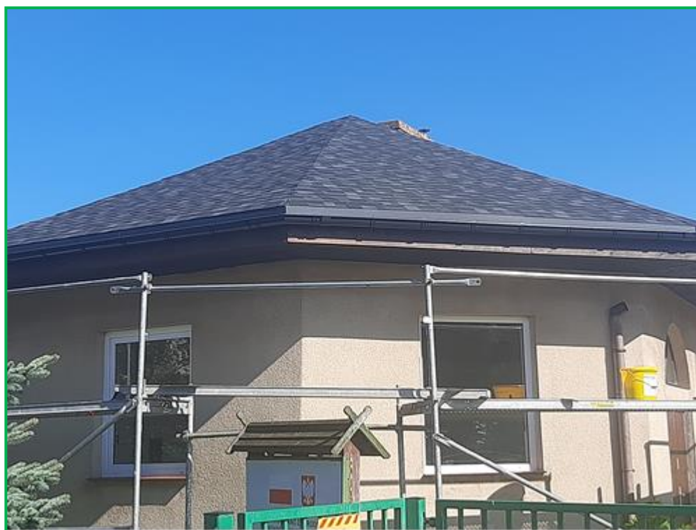
Nowe pokrycie dachowe na szatni w Cekcynie – fot. J. Wilkiewicz
