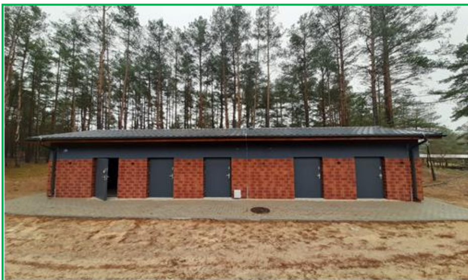
Nowy budynek szatni w Krzywogórcu – fot. J. Wilkiewicz
