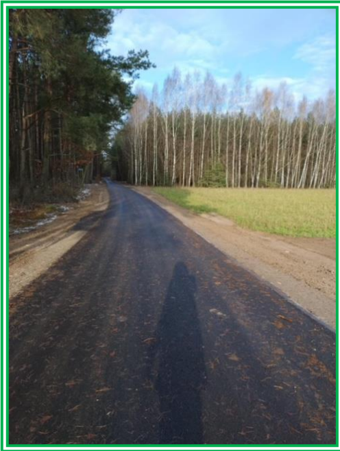
Nawierzchnia asfaltowa w miejscowości Zalesie – fot. N. Rezmer
