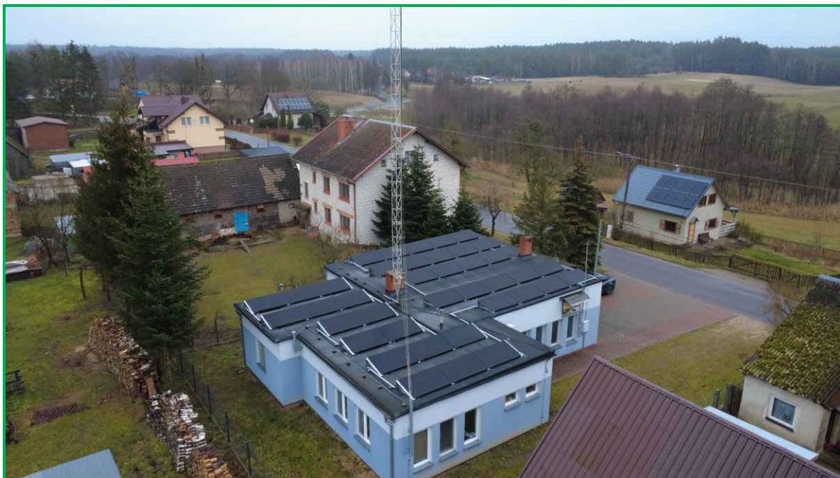
Nowe panele na świetlicy wiejskiej w Ostrowie – fot. UG w Cekcynie
