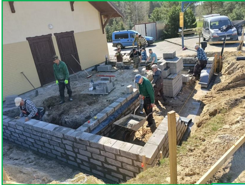
Prace budowlane przy rozbudowie świetlicy w Wysokiej – fot. J. Wilkiewicz
