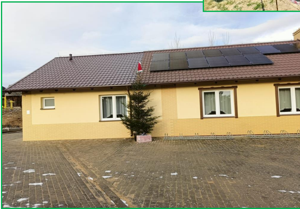
Budynek świetlicy wiejskiej w Wysokiej po rozbudowie – fot. J. Wilkiewicz
