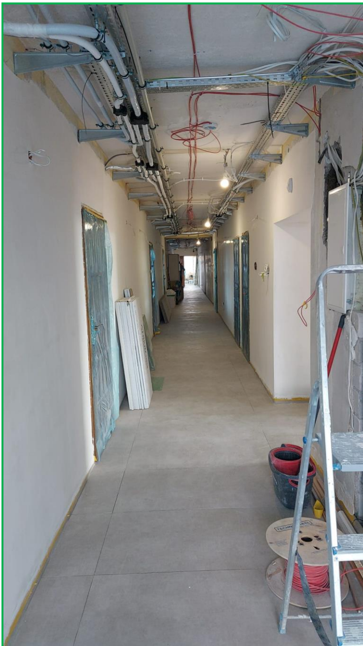
Prace remontowe I piętra – fot. D. Góralski
