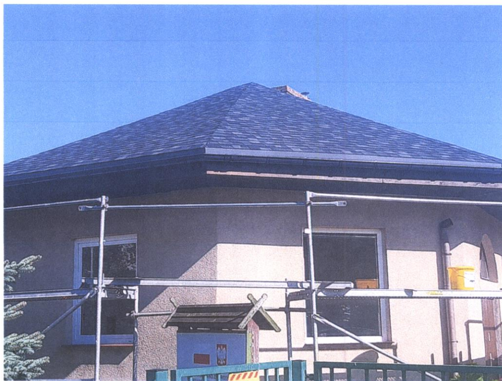
Dach po remoncie na szatni przy ul. Sportowej w Cekcynie
