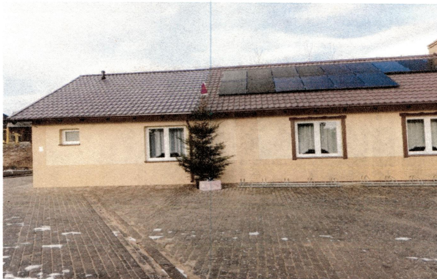
Budynek świetlicy wiejskiej w Wysokiej po rozbudowie.
