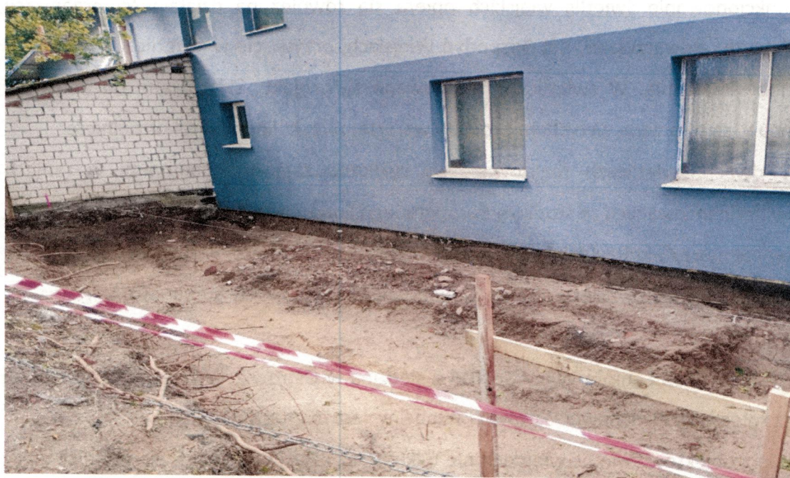
Wytyczenie pod rozbudowę budynku wielofunkcyjnego w Iwcu.
