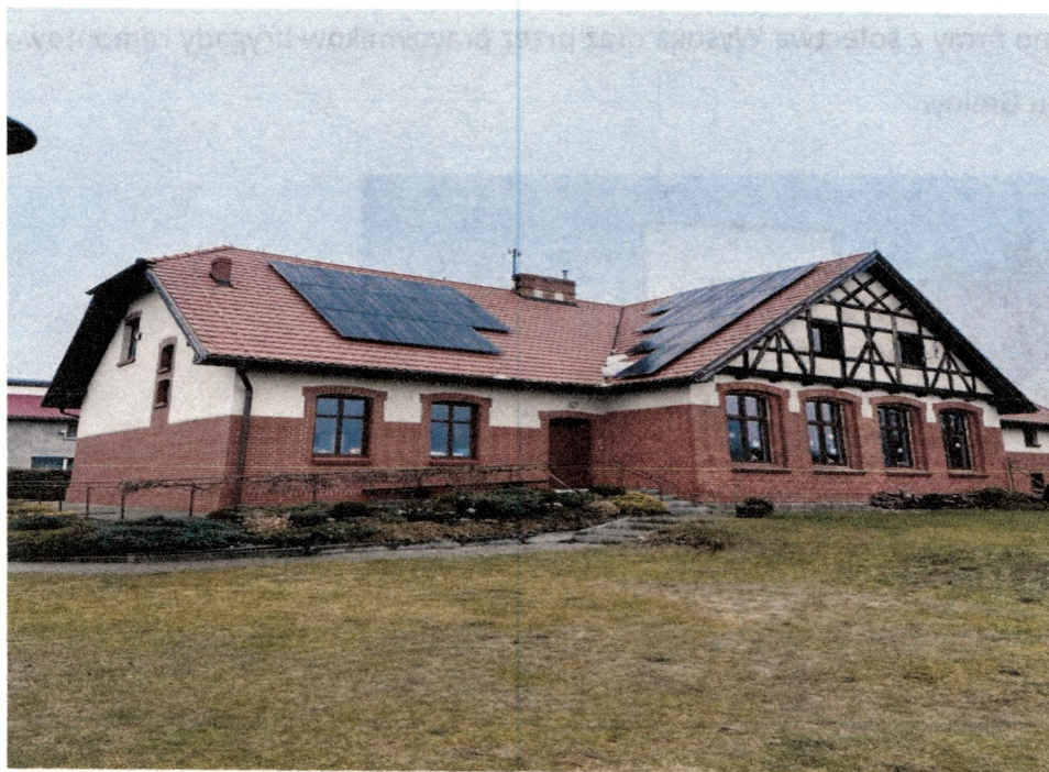
świetlica wiejska w Brzoziu
