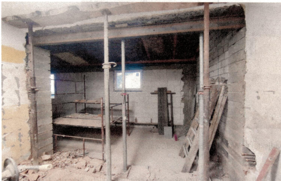
Budynek wielofunkcyjny w Iwcu w trakcie rozbudowy.
