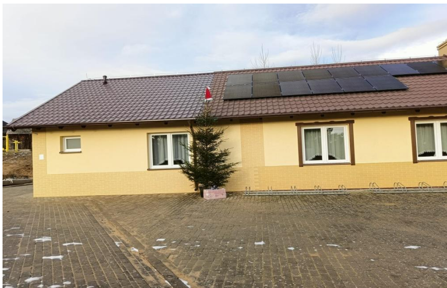
Budynek świetlicy wiejskiej w Wysokiej po rozbudowie.
