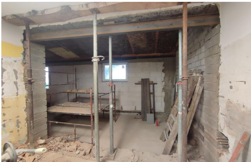
Budynek wielofunkcyjny w Iwcu w trakcie rozbudowy.
