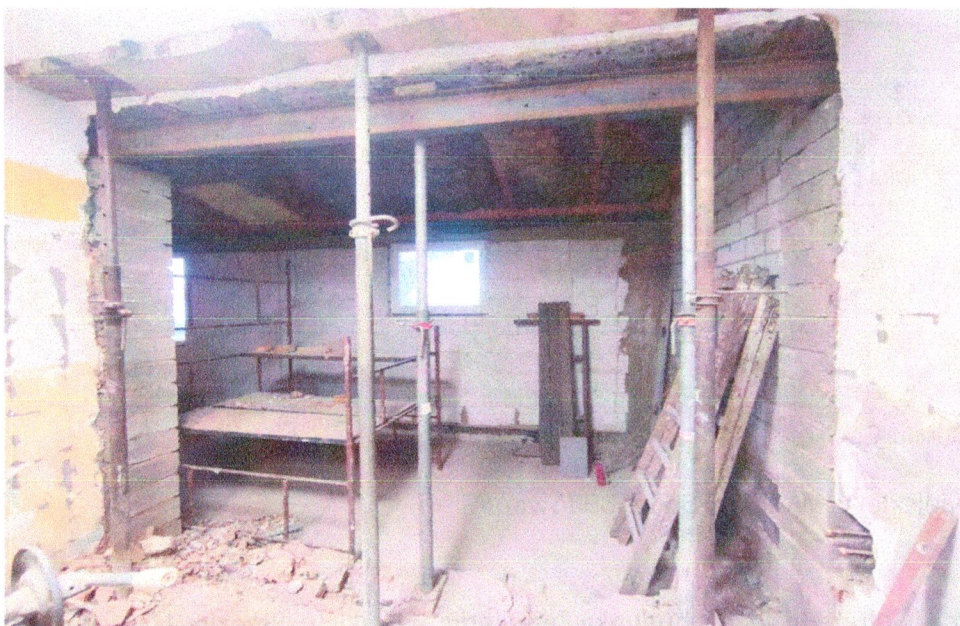
Budynek wielofunkcyjny w Iwcu w trakcie rozbudowy.
