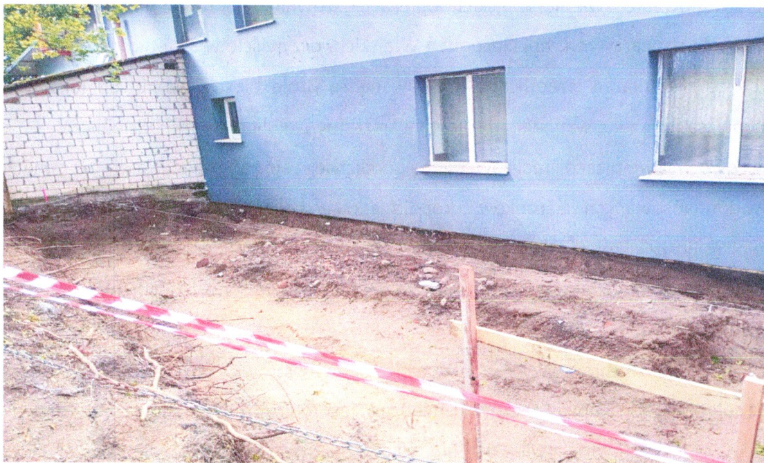
Wytyczenie pod rozbudowę budynku wielofunkcyjnego w Iwcu.
