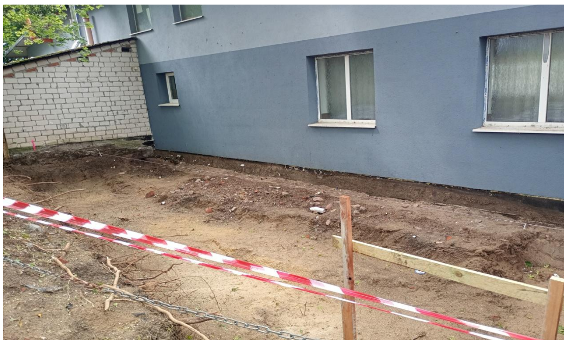
Wytyczenie pod rozbudowę budynku wielofunkcyjnego w Iwcu.
