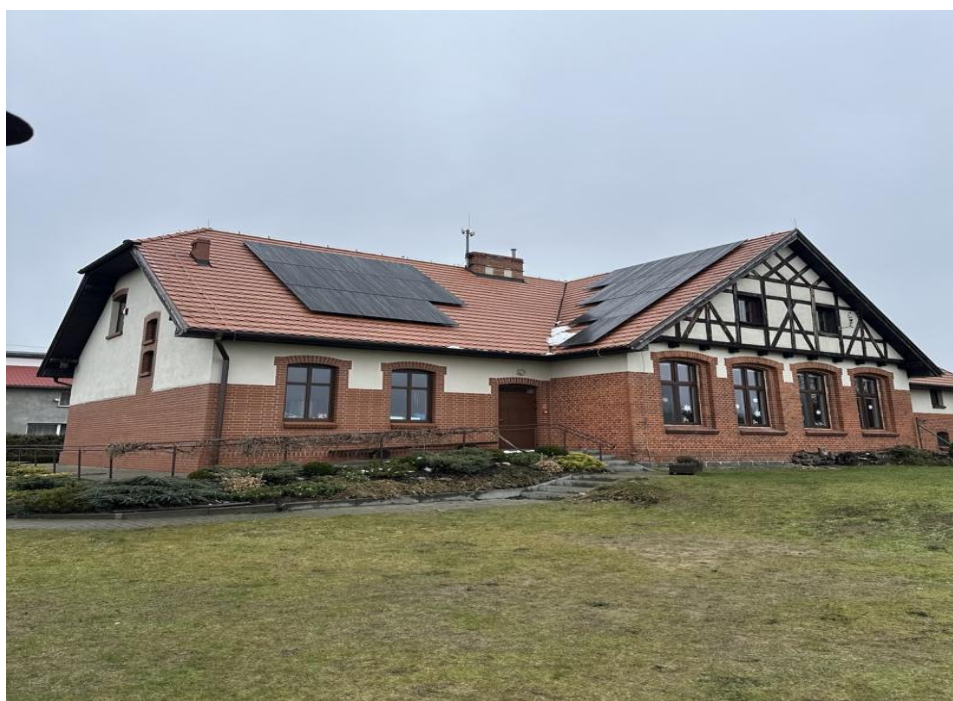
Świetlica wiejska w Brzoziu
